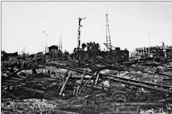
Zerstörter Bahnhof in Treuchtlingen (Bild: www.nordbayern.de )
